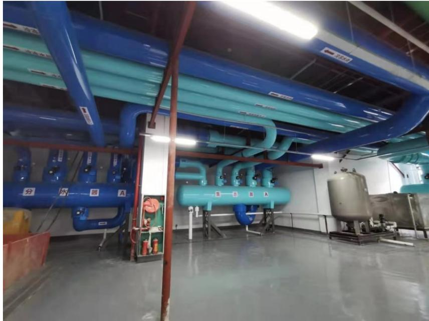
靓壳PVC彩壳□PVC彩壳保温外护系统俗称PVC外壳，是有成型PVC保温外护直管、成型PVC保温外护弯头，成型PVC保温外护三通，成型PVC保温外护管帽等管件组成的保温层的外保护系统□PVC保温外护系统是一种新型质轻、光洁、耐候、耐腐蚀、阻燃持久耐用高性价比、符合美国农业部和食品药品监督管理局FDA的要求的管道及设备的保温外护系统产品，该产品为绝热层材料提供安装便捷、经济有效的保护。具有极好的抗雾霾、抗紫外线、抗老化、耐腐蚀和抗撕裂强度，属于难燃材料，适应于各种管道及设备的保温/保冷系列的外层保护。可替代各种传统金属外保护材料。联系我们-联系我们-联系我们，您身边的PVC管道彩壳保温保护\*\*，让您的工程焕然一新□PVC彩壳管道美化靓化的生产、销售、设计、供应、施工、安装、的专业公司。水暖管线如何美化？管道隐藏技巧！天津UPVC彩壳管道美化工程PVC彩壳
