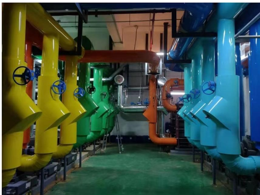
上海靓壳科技是一家提供PVC彩壳管道美化靓化的生产、销售、设计、供应、施工、安装、的专业公司。一应用描述：1. 管件之PVC外壳系统：按管件形状预先制作成型，白色PVC抗紫外线可用于室内，室外；其他多种颜色应用与室内。产品有：各种连接形式的管道系统中的管件，如丝扣连接，卡箍连接，焊接及法兰连接等的弯头，三通，阀门，管接，斜三通，变径和堵头等。2直管之PVC外壳系统：直管外壳经预先加工成管型，安装便利。白色PVC抗紫外线用与室内，室外；其他多种颜色用于室内。应用于：管道保温系统的外保护及管道本身有保护要求的外保护。3设备之PVC外壳系统：平板外壳适用于平面外形或大型圆形表面的外包，如风管，桶，罐及其他设备。4PVC外壳系统的安装方式：胶水粘接，胶带粘接，不锈钢钉固定，硅胶密封。5PVC外壳系统满足以下技术规范要求：联系我们-联系我们-联系我们，您身边的PVC彩壳管道保温保护\*\*，让您的工程焕然一新□ PVC彩壳管道美化靓化的生产、销售、设计、供应、施工、安装、的专业公司。江西管道美化靓化工程管道美
